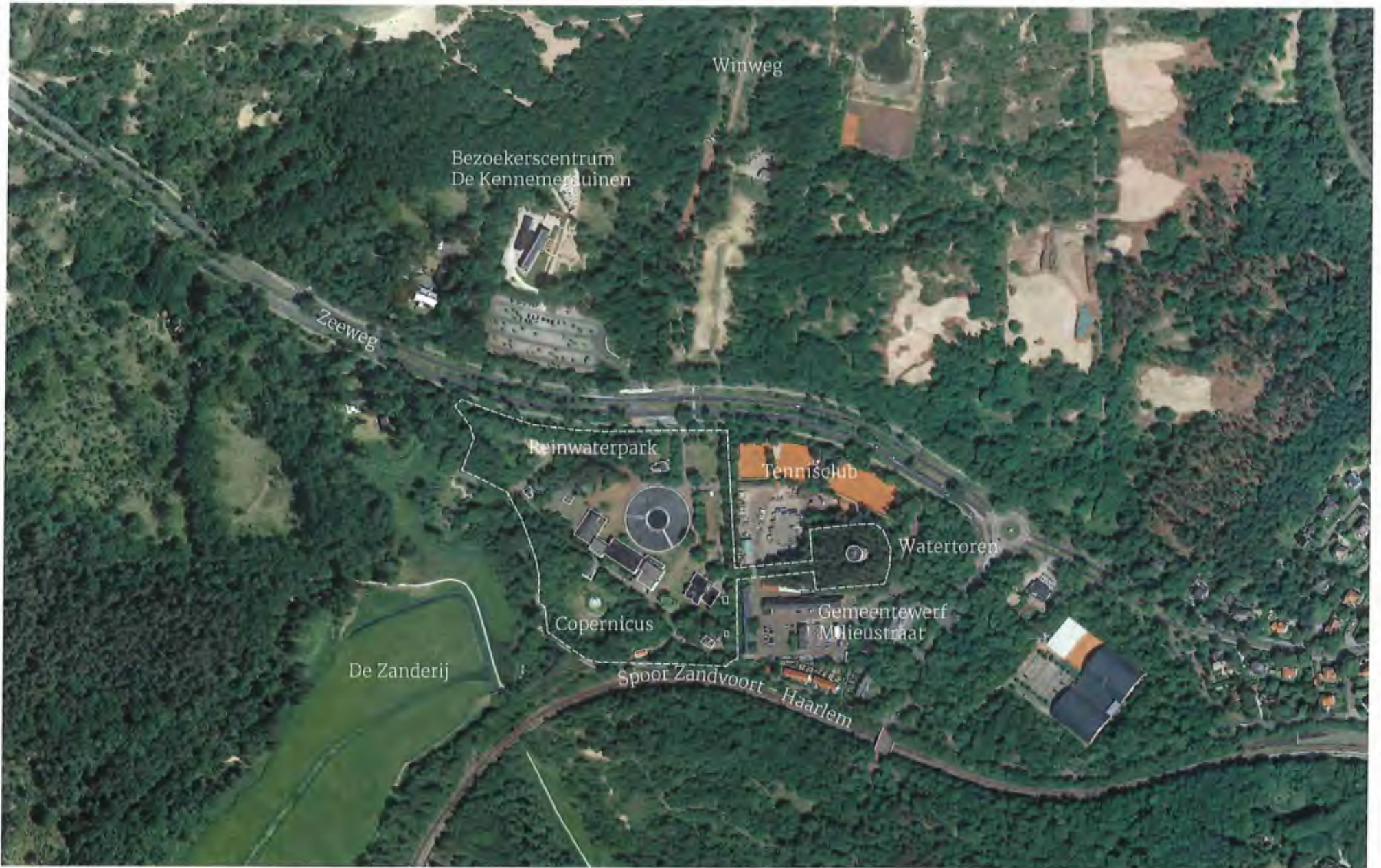
Pompstation Overveen en de directe omgeving. Het terrein ligt tegenover het bezoekerscentrum De Kennemerduinen.
