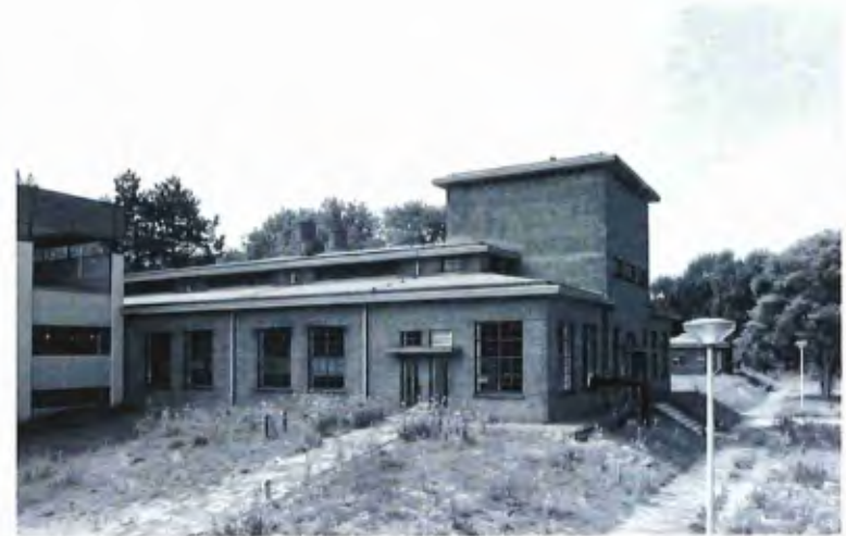
Het filtergebouw uit de jaren 30; te gebruiken als zodanig, of te transformeren naar ondersteunende (kantoor)ruimte voor de toekomstige watermachine.
