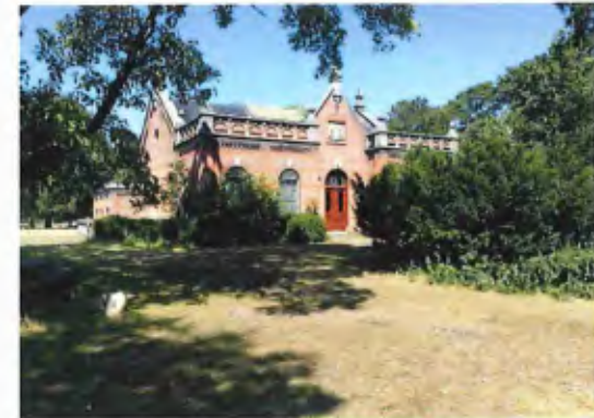
Het machinegebouw nu, de voorkant is achterkant geworden.
