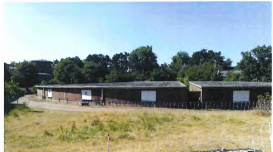
Het grote ronde zandfiltergebouw kan van binnen worden getransformeerd tot extra kelderruimte die nodig is voor de toekomstige watermachine.
